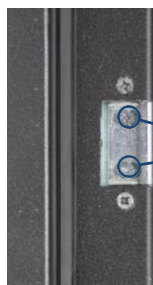
Regulacja docisku skrzydła do ościeżnicy na stojaku zaczepowym
